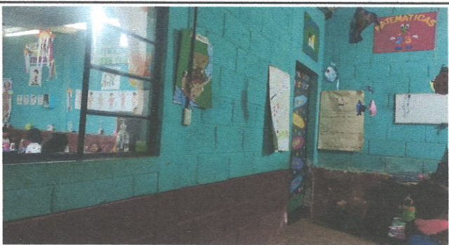
Foto 4: Mejorameinto de pared de modulo
