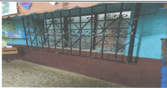
Foto: 5 Mejorameinto de pared de módulo
